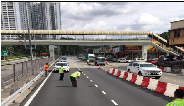
Figure-3. Filling of fill material.
